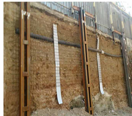
• شمع کوبی دیوار ضلع شرقی پروژه ساختمان آموزشی
