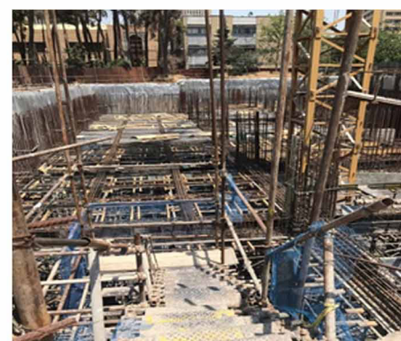
• عملیات اجرای سقف منفی ۲ پروژه ساختمان آموزشی
