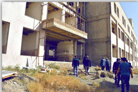
• نمای ضلع جنوب غربی پروژه تاسیس دانشکده روانشناسی
